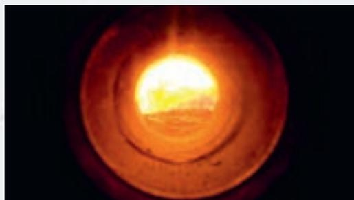
La panetteria industriale Coop di Gossau è la prima nel suo genere ad ospitare un impianto di riscaldamento a cippato in Svizzera. Migliaia di trucioli in legno riscaldano l'olio termico a sua volta necessario a riscaldare i forni.
